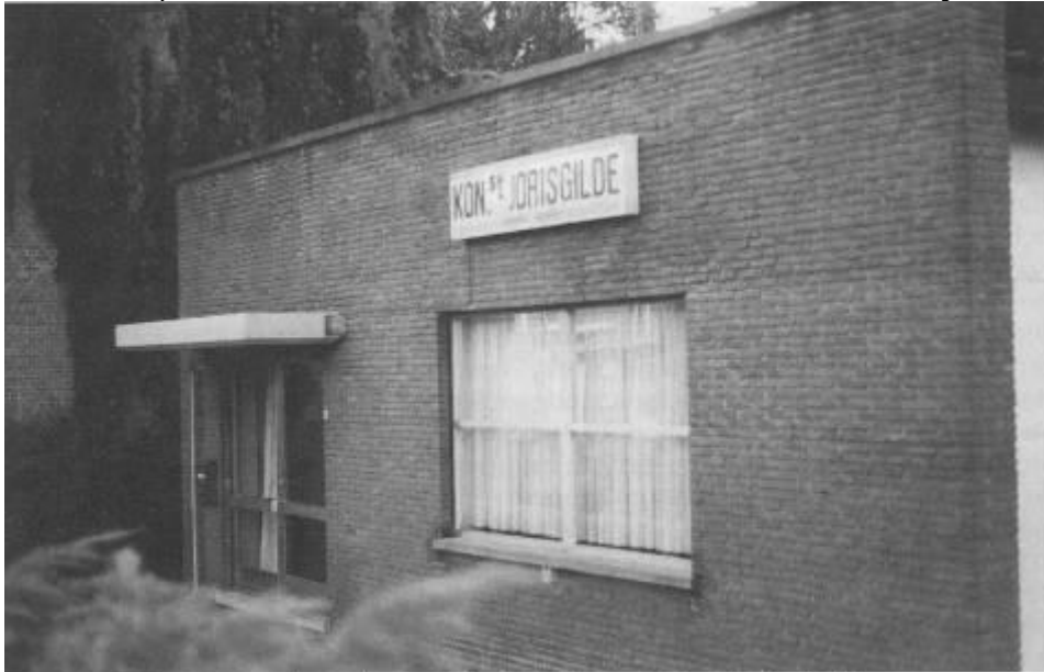
Voorgevel van het huidige lokaal van de Kon. St.-Jorisgilde.
